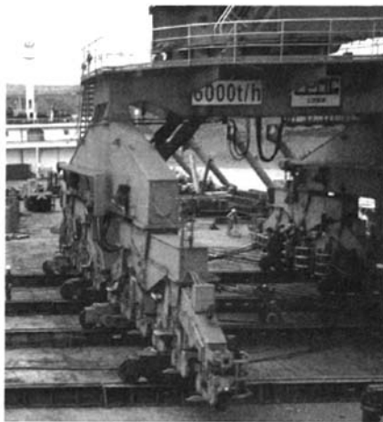
图4 整机滚装上岸(轨道按照码头承载要求布置)
