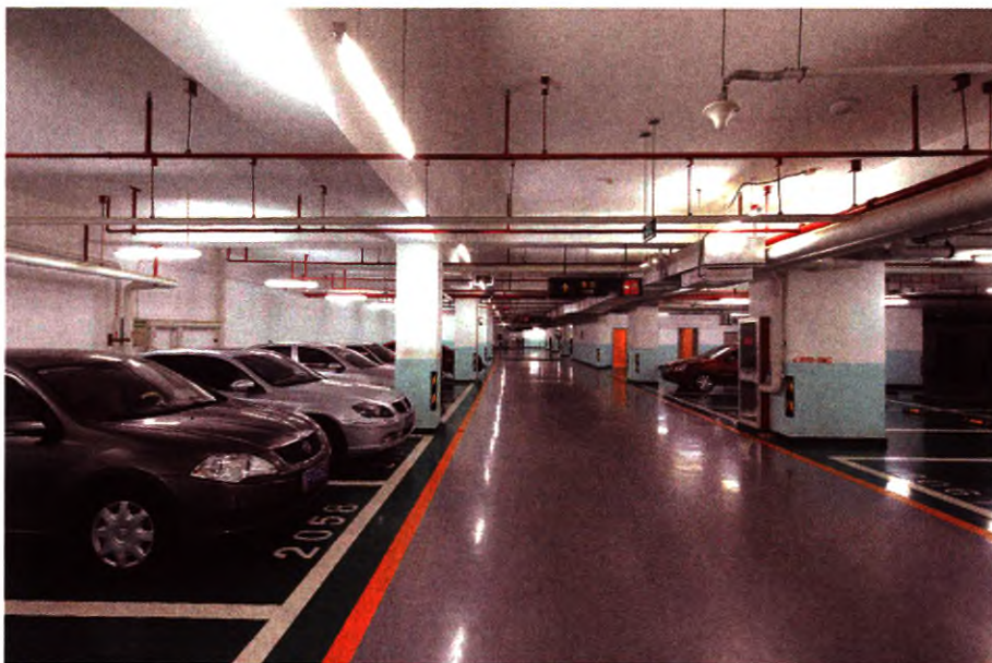
图25 环氧砂浆地坪施工效果
