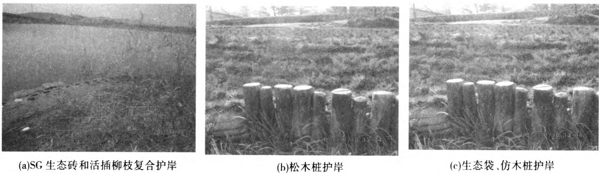
图 5 永定河三种生态护岸措施图
