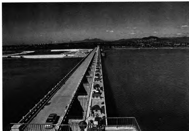
图 5 拦河闸、分洪闸闸室现状
