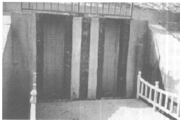
照片 1 混凝土直立滑槽及箱端支承滚轮
