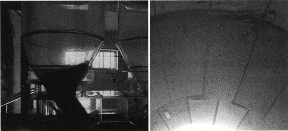
图 4 炉料对料罐衬板的冲击
