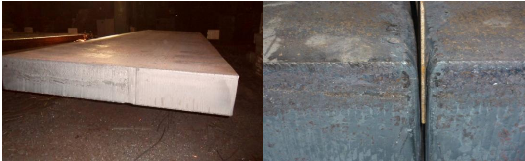
图 7 实际切缝情况
