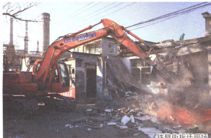
铁壁街拆迁现场
