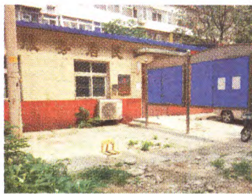
七北居委会门前拆除前
