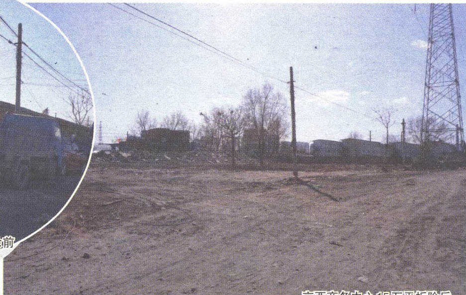
京西商务中心 15万平拆除后
