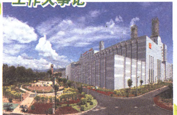
关停京能、高井两大燃煤电厂 建成全市最大西北热电中心
