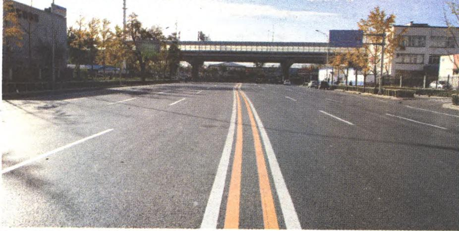
本报讯(通讯员沈成勇 王璐)金顶街始建于2004年,南起阜石路辅路,北至金顶北路,总体呈南北走向,全长570米,为城市次干路,两上两下四机动车道。由于近几年交通量增长迅速以及道路的长期使用,此条道路整体路段已经严重破损。为了改善城市道路使用功能,给市民出行提供良好的交通环境,对此段道路进行大修。金顶街道路现状两侧人行步道宽5米,机动车道路面宽16米,机非隔离带宽度4米,非机动车道宽度10米。本着提高道路的使用性能,美化道路环境的理念,此次大修施工全线挖除旧路结构新建路面,施工中拆除原有机非隔离带,两侧各增加一条车道,以提高通行能力。
