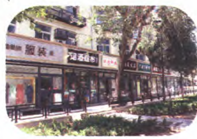
八角西街商业街改造后
