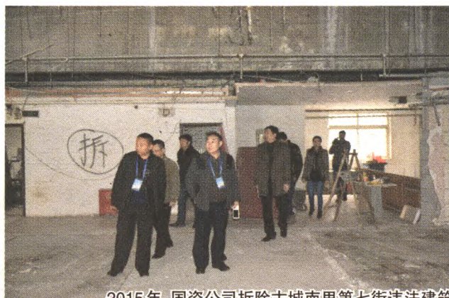
2015年,国资公司拆除古城南里第七街违法建筑
