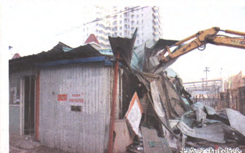
拆除违法建筑
