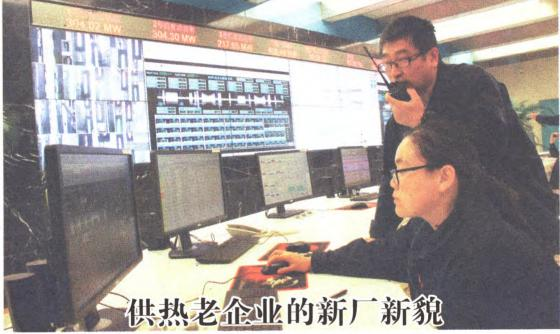
本报讯(记者宋光镇)供热不再用燃煤机组,取而 代之的是燃气热电联产机组;加热升温不再看火眼添 煤,而是动动鼠标电脑操作……日前,记者在北京高 井热电厂感受到老企业的新厂新貌。
