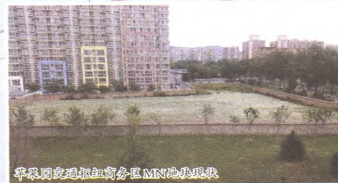
翠泉园交通枢纽商务区MN地块实景图
