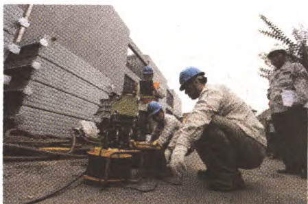
国网北京石景山供电公司工人冒着酷暑在广宁路停电改造施工现场施工。改造完成后将有效提高该地区区域内设备的健康水平,优化地区网架结构。
