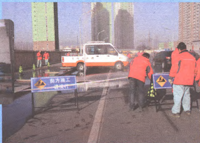
管网抢修现场
