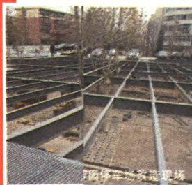
立体车场改造现场
