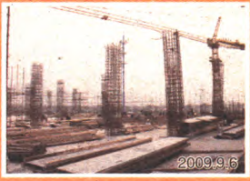
爱玛裕家居购物广场建设中
