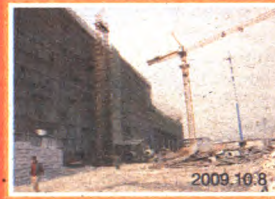
爱玛裕家居购物广场建设中
