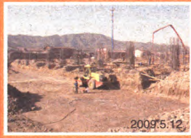
爱玛裕家居购物广场建设中
