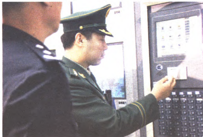
检查消防安全情况
