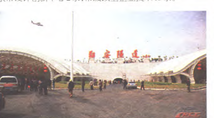
获奖项目应用在“厦门翔安海底隧道”国家重点工程
