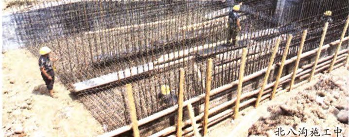
北八沟施工中
