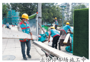
立体停车场施工中
