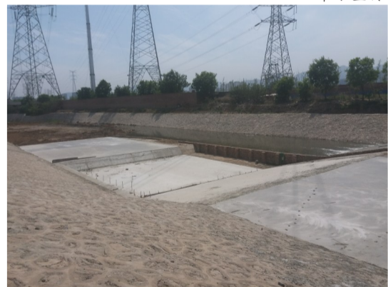
高井沟治理工程完工
