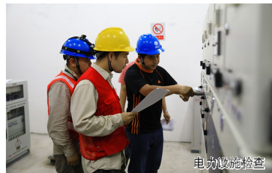
对电力在施工程进行安全检查
