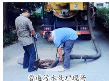
管道污水处理现场
