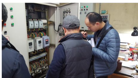
玉泉路11号院供热锅炉房安全检查
