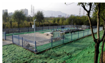
麻峪村污水处理站
